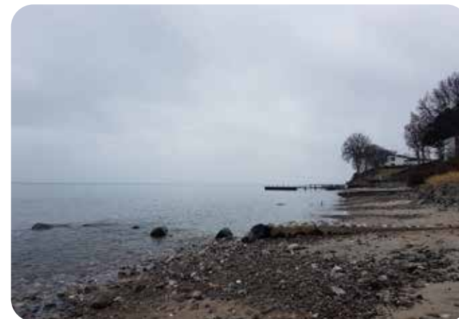
Billede 3: Eksempel på nedbrudt betonhøfde.
