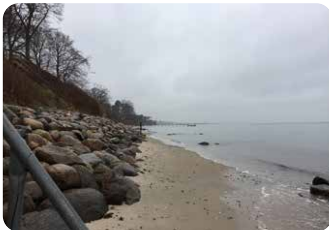
Billede 2: Eksempel på skræntfodssikring.
