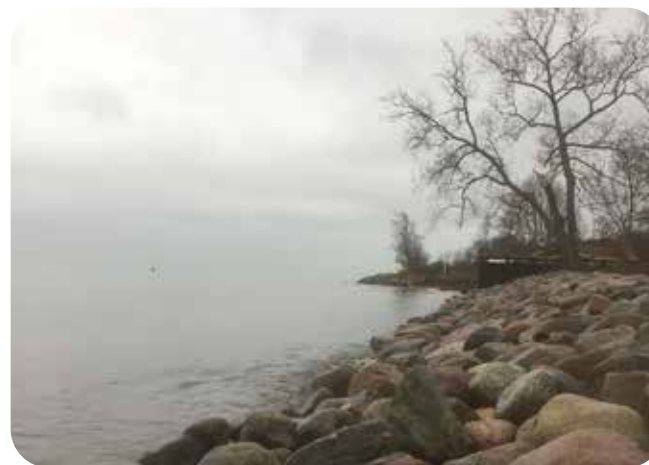
Billede 5: Eksempel på skræntfodssikring, der fylder på stranden.
