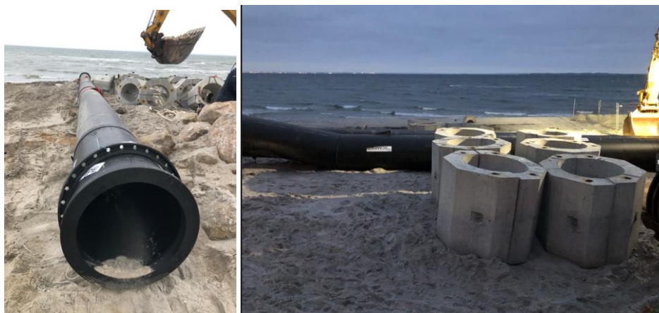
Figur 2-5 – Oplæg af ledning og ballastklodser på sandfodringen forud udtrækning i Øresund.
