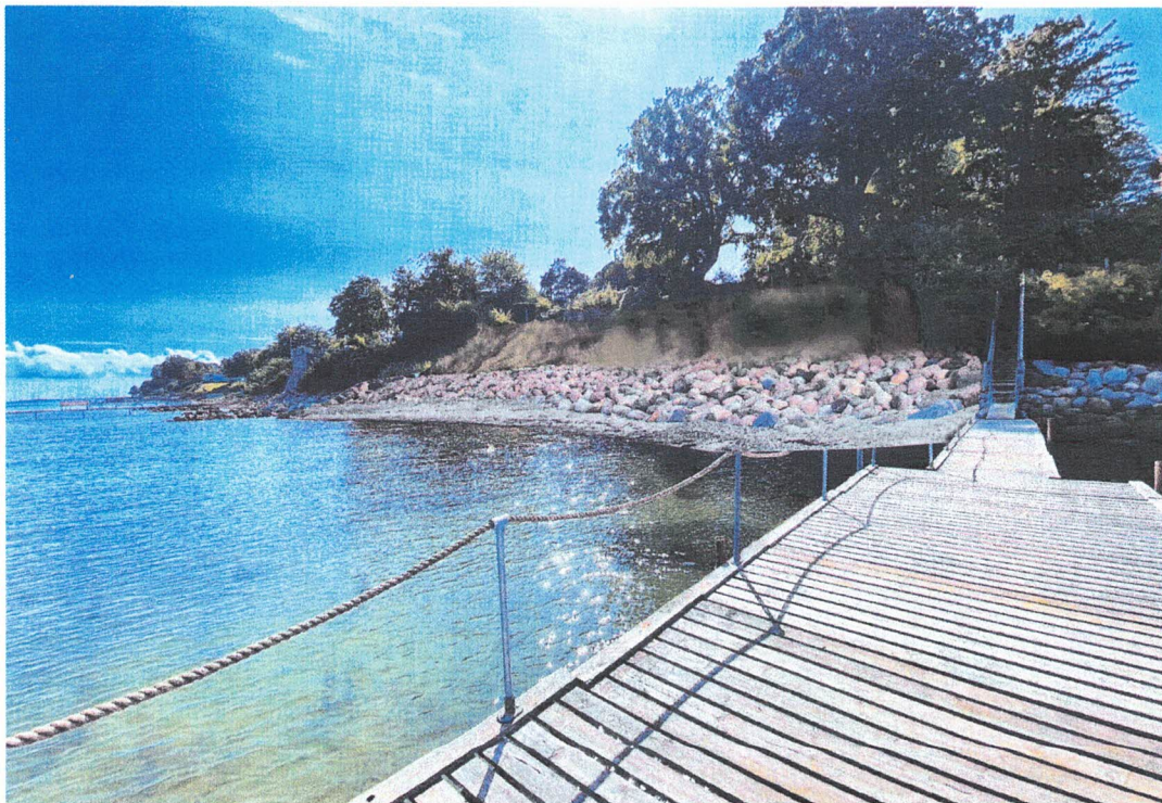
Egtoftevej 10 efter etablering af kystbeskyttelse. De sten, der anvendes, vil være mere kantede og mørkere end de viste, nærmest sorte. Se foto fra Rungsted Havn, Sydmoen.
