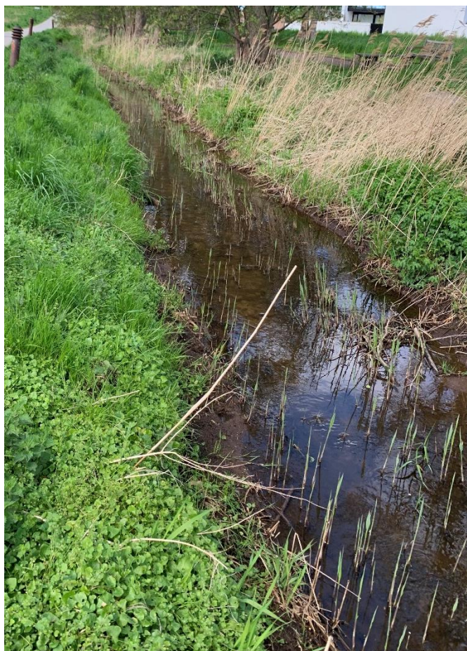
Figur 7: Strækning G. Overbredt, blød bund og kraftig opvækst af tagrør. Foto maj 2022.
